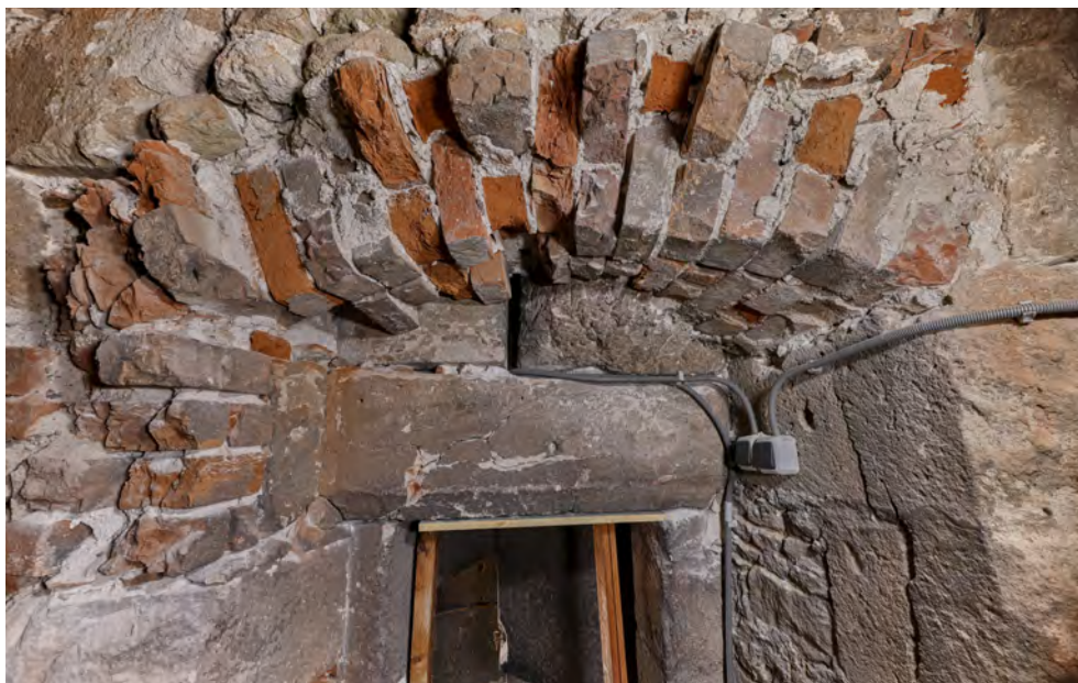
Obrázek 7: Porušený překlad a cihelná klenba
